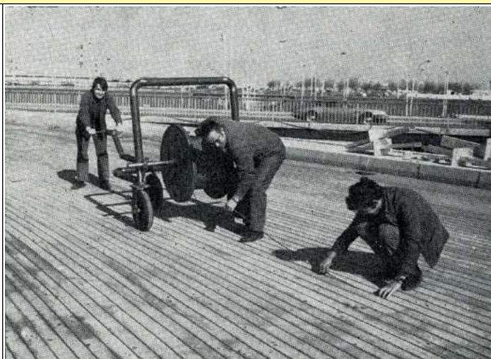
1968 Installazione del nastro scaldante su una rampa di accesso a una piattaforma di parcheggio per autobus, all'aeroporto di Orly, vicino a Parigi ( Electric heating of the roadways, by Robert Félix, 1971, Ultimheat Museum* )
